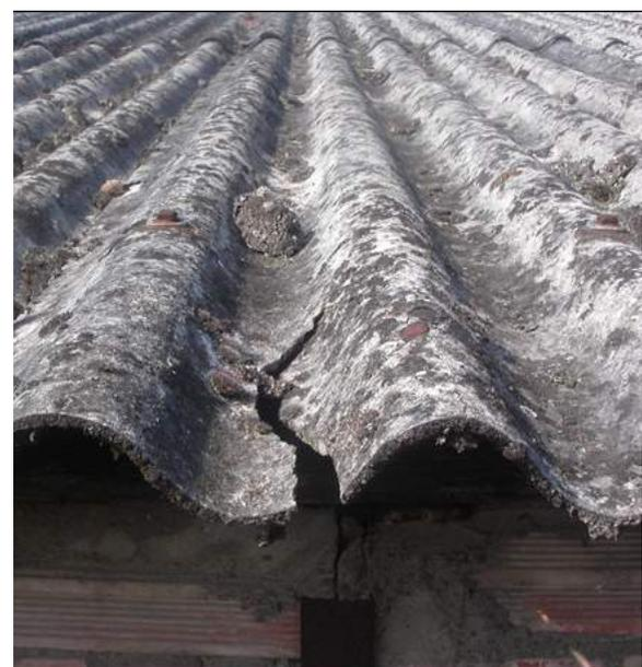
Il y a plusieurs milliers de mètres carrés de toiture dégradée en amiante-ciment
