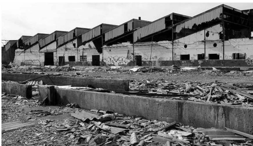
Démantèlement de la fabrique Uralita de Getafe au Sud de Madrid.
