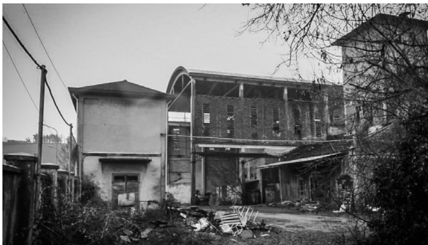
Ruines de la fabrique Eternit de Casale Monferrato en Italie.
