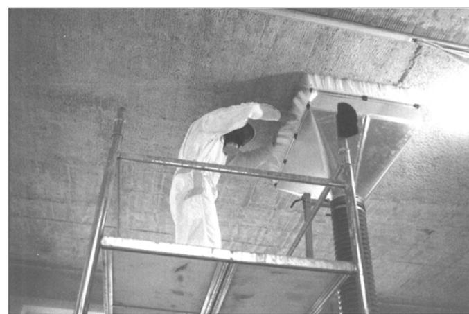
Déflocage d'une dalle en béton armé au moyen d'un entonnoir aspirant.
