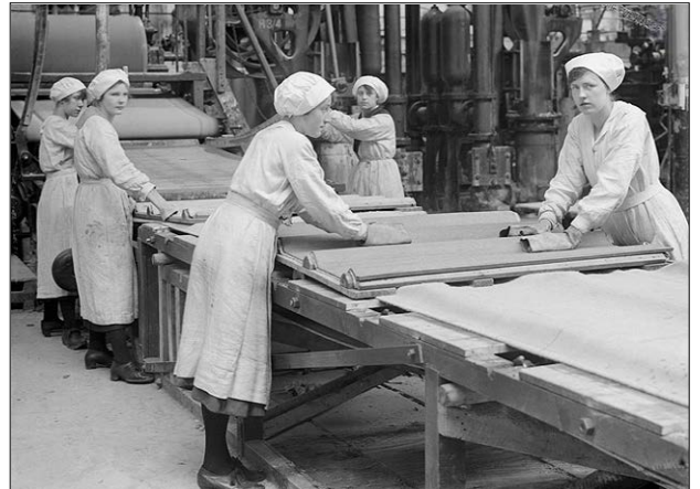
Des travailleuses moulent l'amiante-ciment encore frais sur des matrices ondulées pour en faire des plaques de toiture (1918)
