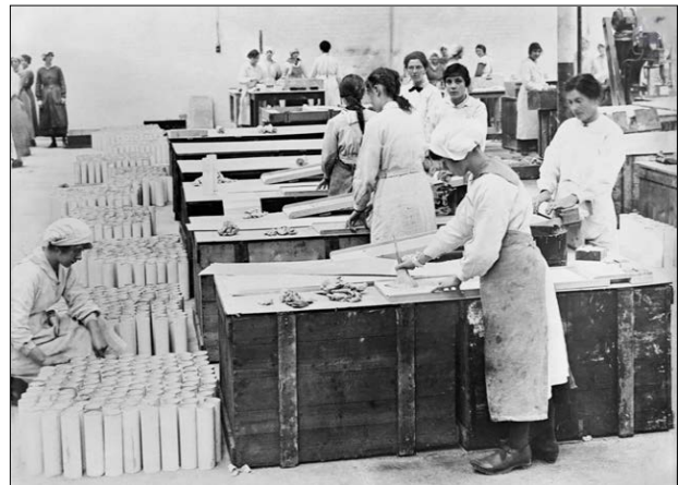
Des femmes enroulent et peignent les cylindres en amiante-ciment pour des y loger des obus fumigènes (1914).
