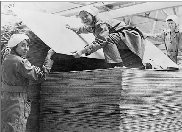
Des travailleuses empilent des plaques planes en amiante (1918).
