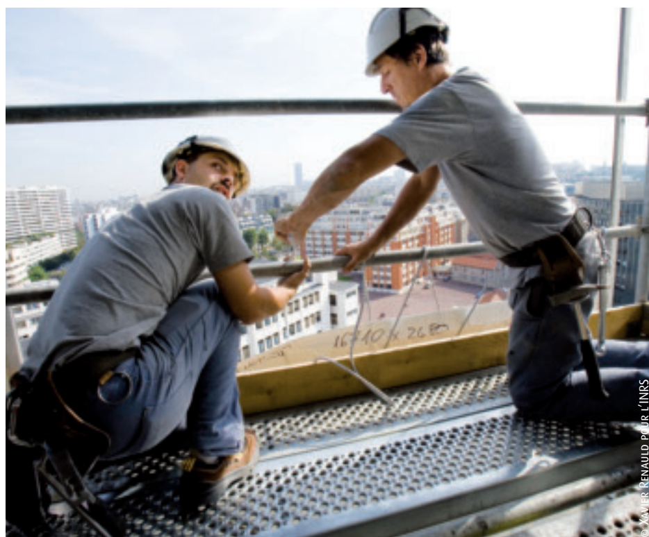
La bâche est mise en place à partir de la plate-forme haute : les bordures renforcées par des joncs coulissent dans une glissière fixée au cadre de l'échafaudage.
