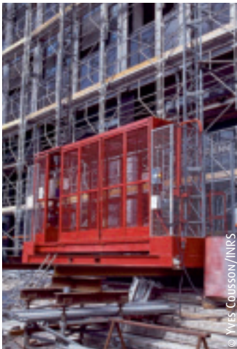
La centaine de travées de l'échafaudage à montage en sécurité ceinture l'immeuble de 18 étages et sert de support à la bâche et au confinement extérieur.
