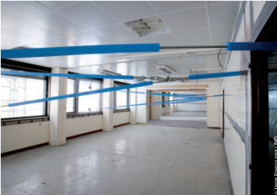
Environ 800 câbles relie l'échafaudage à autant de points d'ancrage fixés dans le noyau central de l'établissement.
