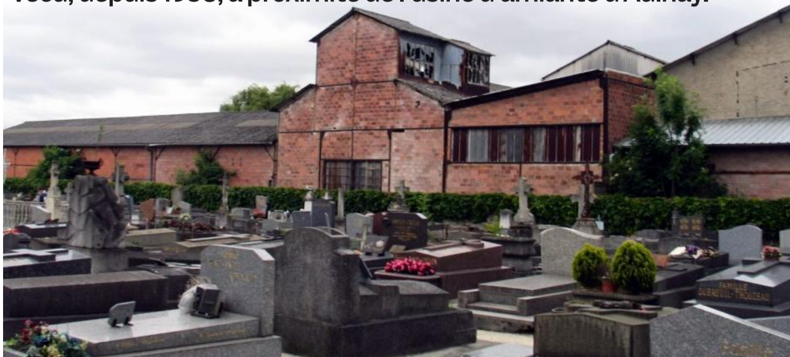
Aulnay-sous-Bois, juin 2008. Voici l'usine d'amiante du Comptoir des minéraux et matières premières (CMMP), située à côté de l'ancien cimetière, avant sa démolition. Salariés et leurs familles, habitants du quartier, écoliers... Ils sont des dizaines de milliers susceptibles d'avoir respiré des fibres d'amiante entre 1938 et 1975. (LP/G.B.)
