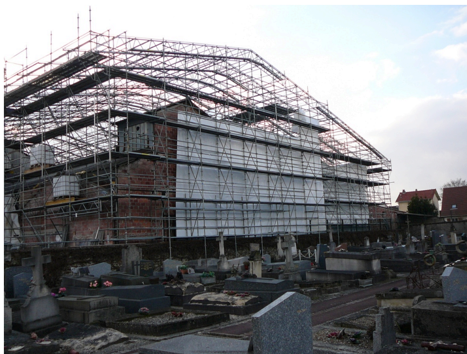
Photo de la mise en place du confinement autour du Cmp, prise depuis le Cimetière Source : Collectif des Riverains
