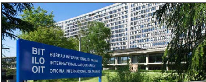
Le bâtiment du BIT à Genève, construit en 1975.
