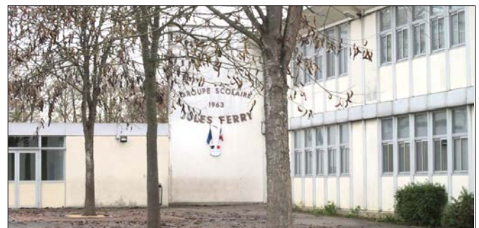
L'école Jules Ferry, bâtie en 1962 à Noisiel, France, bourrée d'amiante sera rasée.
